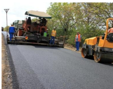
Construcția drumului Ștefan Voda –Talmaza
