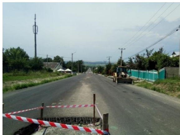
Proiectul „Reabilitarea și modernizarea drumului de importanță regională str. I. Spirin din or. Cahul”
