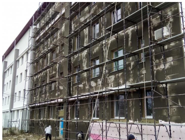
Lucrări în cadrul proiectului „Reabilitarea termică a clădirii IMPS „Spitalul raional Cantemir (bloc chirurgical)”
