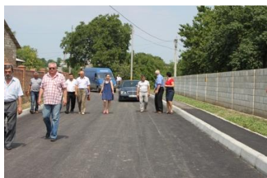
Renovarea drumului din Zaim
