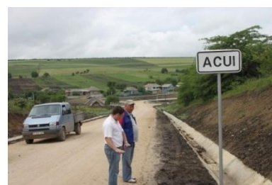
Construcția drumului Dimitrova - Acui
