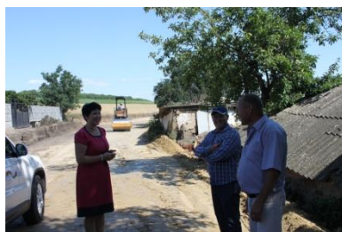
Construcția drumului Codreni - Sagaidacul Nou
