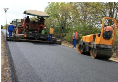
Construcția drumului Ștefan Vodă - Talmaza
