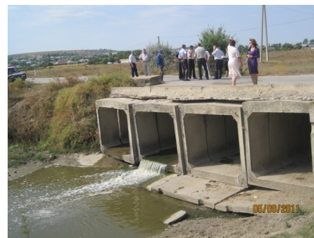
Podul peste râul Cogâlnic care urmează a fi reconstruit în cadrul proiectului implementat de ADR Sud
